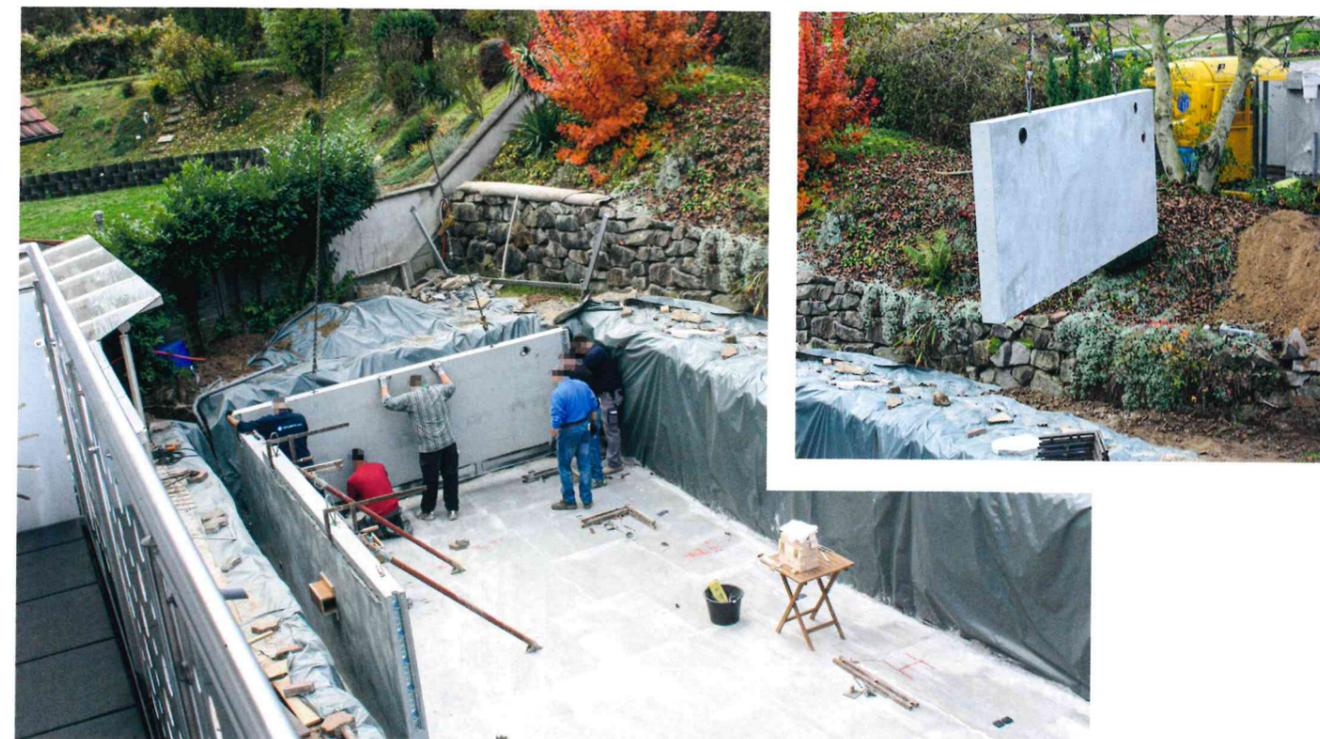
Diese Bilder zeigen zwei Arbeitsschritte von einer Poolbaustelle mit Betonfertigteilen. Durch diese Methode sind kurze Bau- und Montagezeiten möglich. Denn durch die Vorfertigung können alle notwendigen Einbauteile ins Fertigteil integriert werden. [www.spuergin.com](http://www.spuergin.com)
