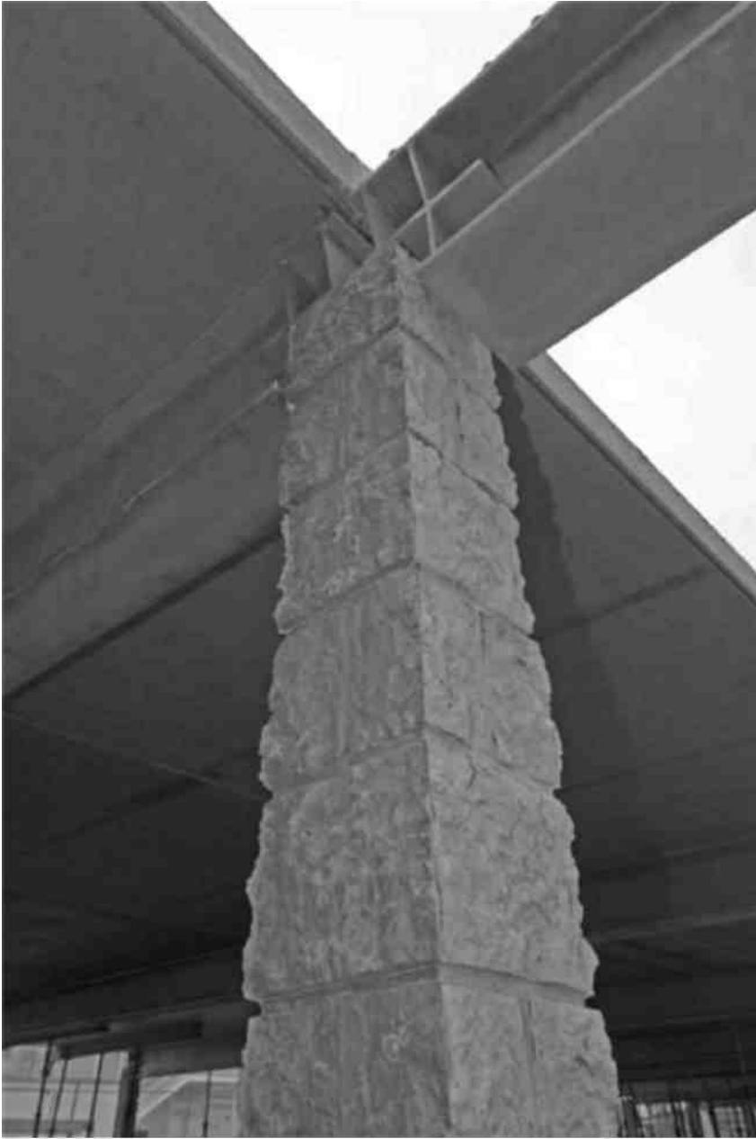
Einfach war die Montage für das ausführende Bauunternehmen Fischer-Bau aus Offenburg.
