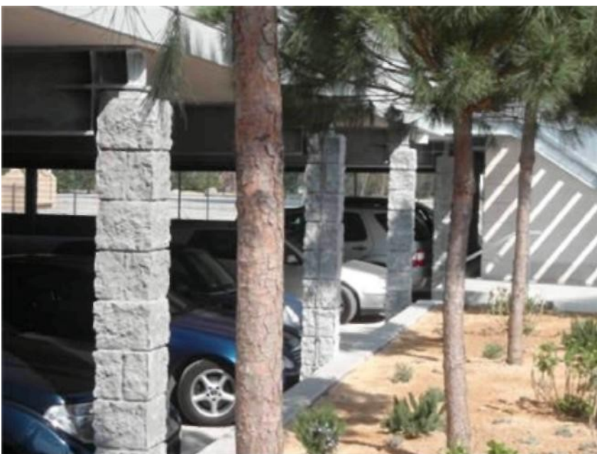
Harmonisch fügt sich so das neue Parkhaus in ein fast mediterranes Umfeld ein.
